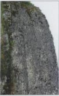
Les murs en pierre sèche sont des constructions durables, qui s'intègrent dans le milieu et qui servent de refuge pour la faune et la flore. L'absence de joint permet le drain de l'eau à travers les « pores » du parement et garantit la stabilité du terrain contenu.
