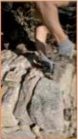
2 - Une fois l'emplacement des montants déterminé, creuser profondément dans le sol 2 trous à la barre à mine en suivant le fruit du mur.
